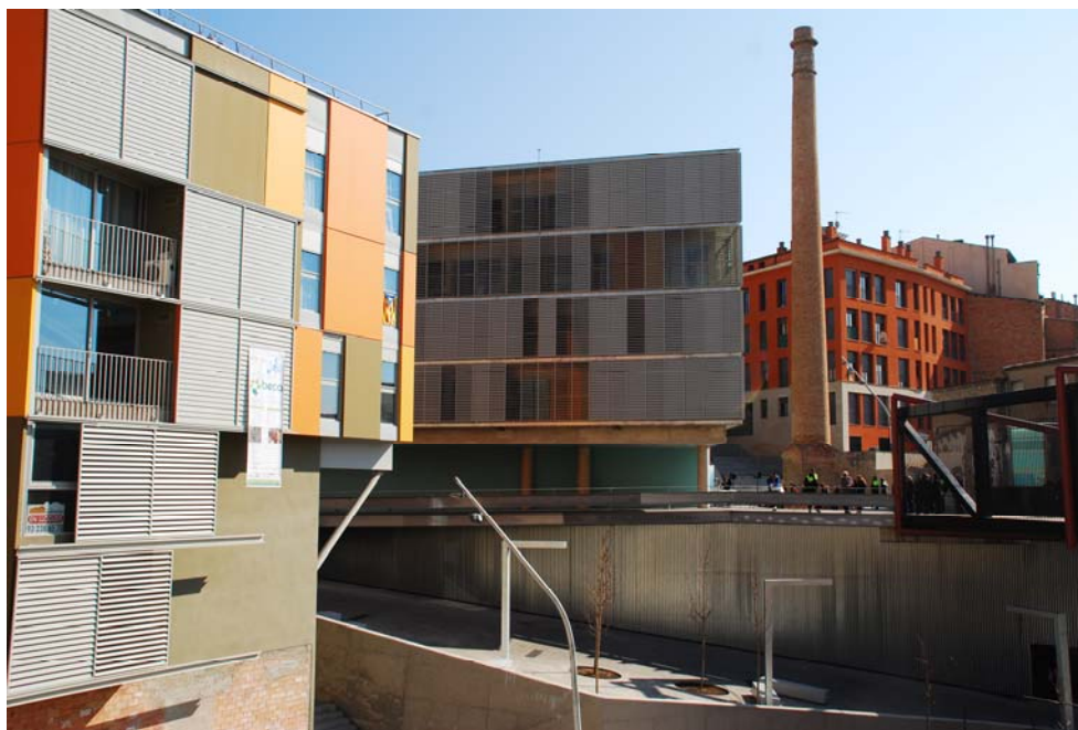
Vista general de les unitats d'actuació 2 i 3-5
